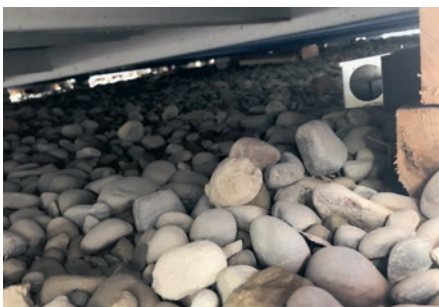
Die Nagerbekämpfung reduziert die Ausbreitung.
